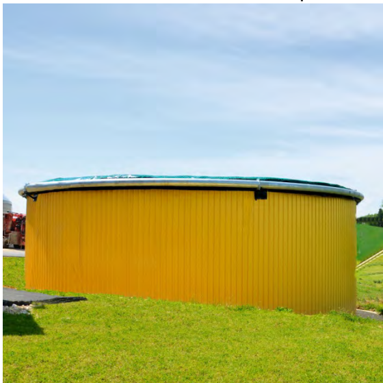
Langzeitwärmespeicher, Quelle: Cupasol
